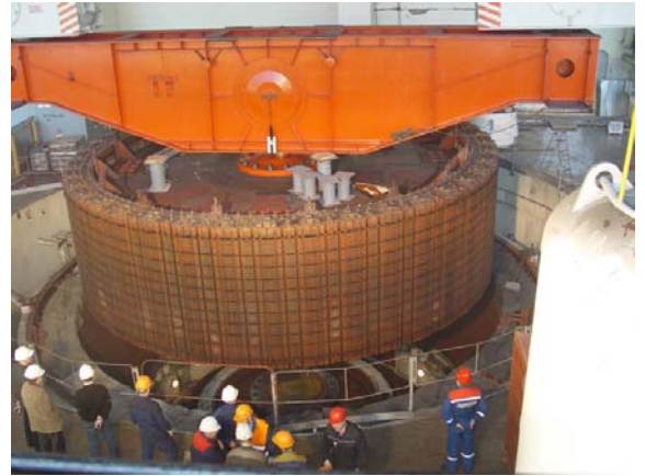
Рис. 2. Подъем ротора гидроагрегата №4
