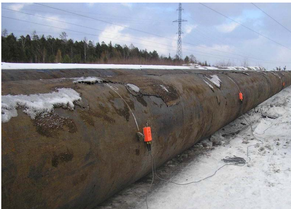
Рис. 7. Эксперимент по интегральной толщинометрии на участке трубопровода со снятой изоляцией [9]
