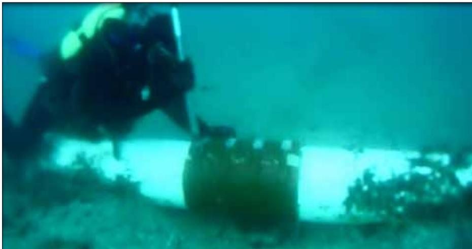
Лайнер устанавливается таким образом, чтобы валик усиления сварного стыка располагался между краями лайнера для избегания возникновения концентраторов напряжений на шве и предусматривает возможность в случае необходимости адаптации его формы под конкретные условия посредством механической обработки.
