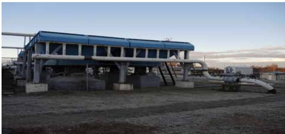
Рисунок 10. Испытываемый аппарат воздушного охлаждения
