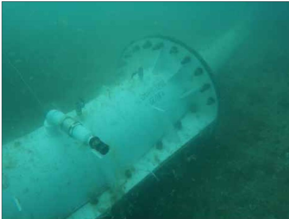
Изготовленная муфта СМАРТ-325БС «Белуга» весом 593 кг имеет габаритные размеры 2097 мм x 110мм x 970 мм. Для заливки использовалась сухая строительная смесь «Бастион» РРбт (сертификат соответствия № РОСС RU. АВ86. Н07350). Подача осуществлялась бетононасосом, объем заполнения смесью составляет 520 кг.
